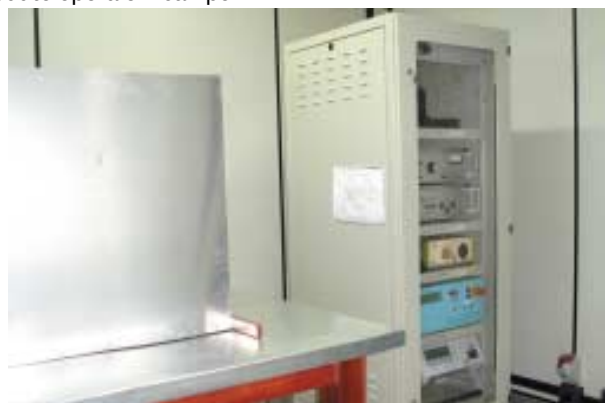
Novo laboratório adequado à exigências de normas internacionais
